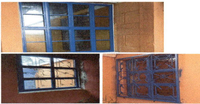
Foto 5: Ventanas de metal con vidrio
