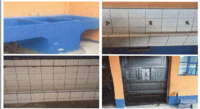
Foto 4: Puerta de metal, pila y azulejo
