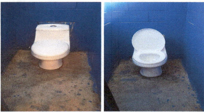
Foto 3: Cambio de inodoros
