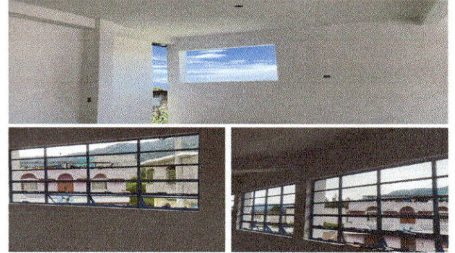
Foto 2: Acabado de repello de aula y ventanas
